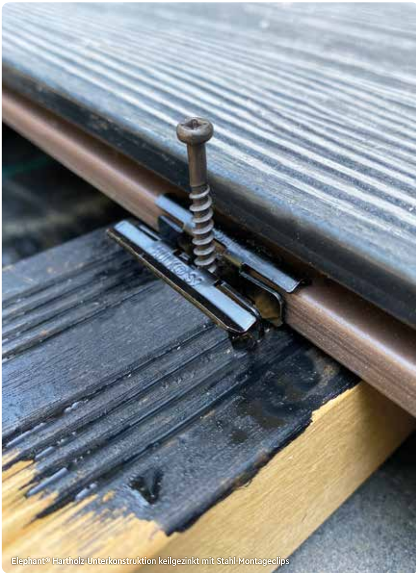
Elephant® keilgezinkte Hartholz-Unterkonstruktion mit DuoWood-Clips
