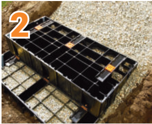
Erste Stufe einsetzen, mit Kies oder Beton befüllen; alle weiteren Stufen mit den Verriegelungen und den Führungsschienen montieren.
