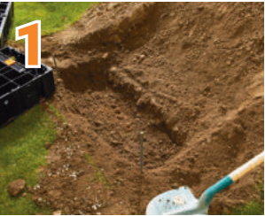
Vorbereitung: Boden für den Hang abtragen und Platz für die erste Stufe festlegen.
