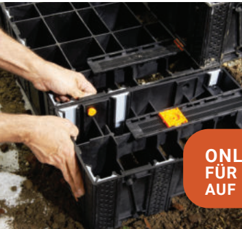
Holzverkleidung: Trägerbalken in die dafür vorgesehenen Räume einsetzen und die Terrassendielen befestigen.
