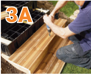
Holzverkleidung: Trägerbalken in die dafür vorgesehenen Räume einsetzen und die Terrassendielen befestigen.
