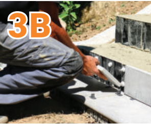
Natursteinplatten: Stufen mit Porenbeton, oder Beton befüllen und die Platten kleben.
