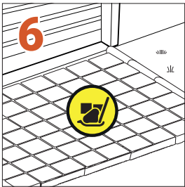
Verlegung der Pflastersteine.
