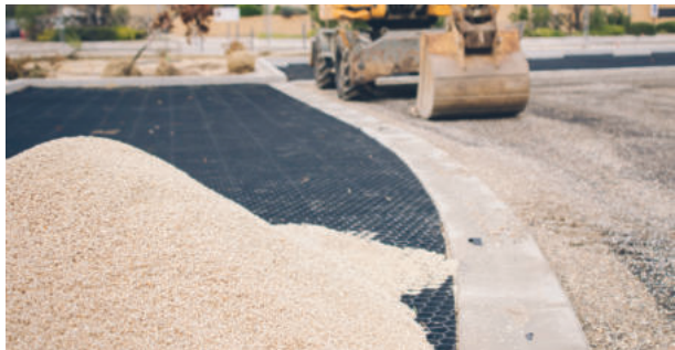
URBANGRAVEL® Unterlegplatten verlegen
