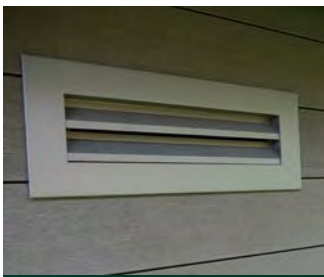
2 Aluminium Lüftungselemente in der Seitenwand
