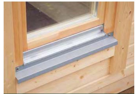
Fenster mit Metall-Fensterbank
