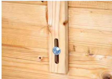
Sturmleiste bei Wandstärken 28 und 40 mm
