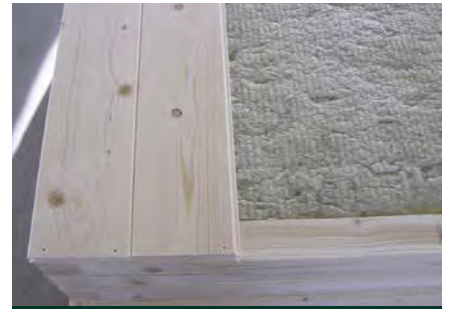
Gedämmte Zwischendecke im Saunaraum
