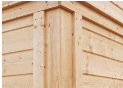
Umlaufende Leimholzkonstruktion
