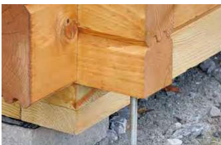
Gewindestangen ab Wandstärke 44 mm
