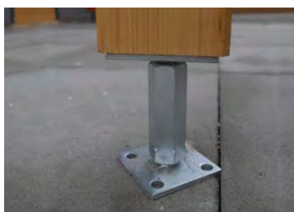
Verstellbarer Pfosten
