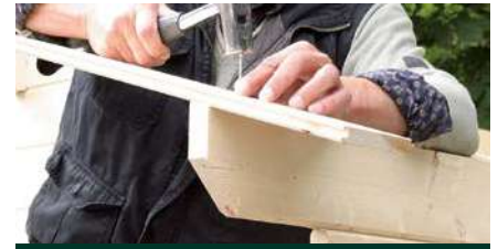
Abgeschrägte Seitenwandbohle
