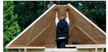
Vorgefertigte Dachelemente
