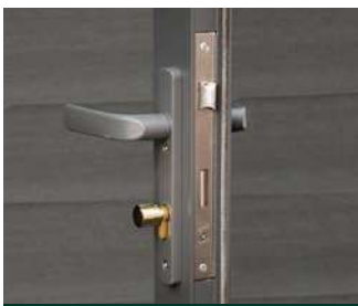
Zylinderschloss und Türdichtung
