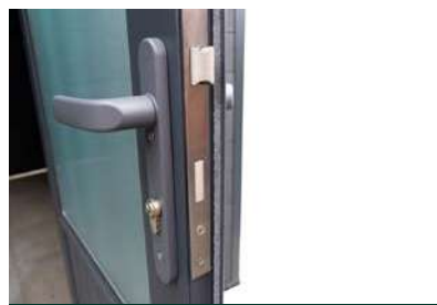
Zylinderschloss und Türdichtung
